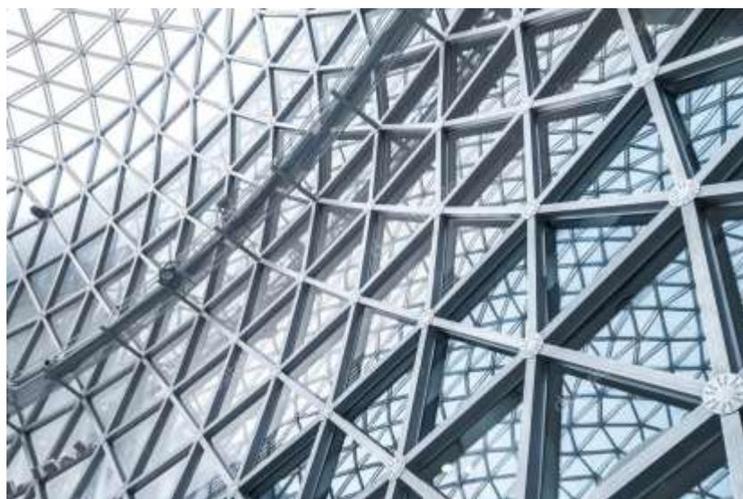
Рисунок 59. Шаростержневая конструкция [20]
