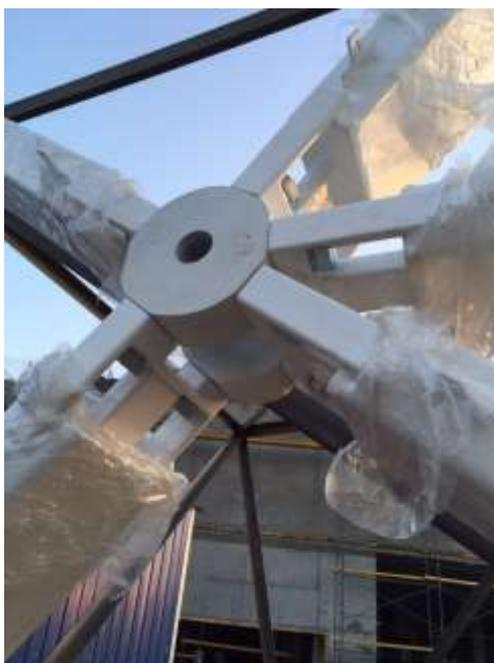
Рисунок 58. Шаростержневая конструкция [20]
